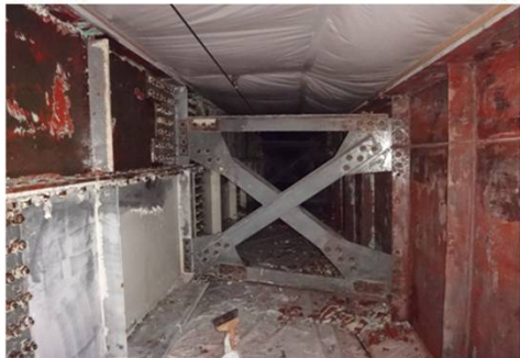
有害物質含有既存塗膜 掻き落とし作業状況①
