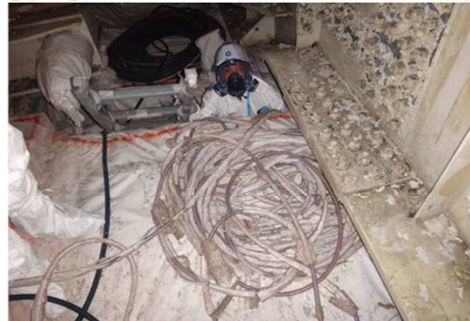
エアラインホース 現場使用状態①
