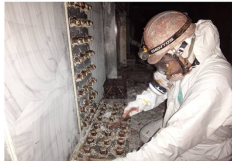
有害物質含有既存塗膜 掻き落とし作業状況③ 電動ファン付き呼吸用保護具装着
