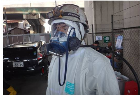
水系塗膜剥離剤 スプレー塗付作業者 エアラインマスク装着状態
