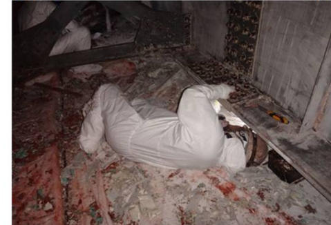
有害物質含有既存塗膜 掻き落とし作業状況④ 電動ファン付き呼吸用保護具装着
