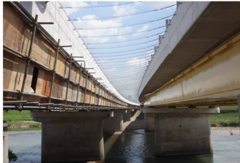
高速道路会社 水系塗膜剥離剤採用現場 足場: 板張防護足場 外景①
