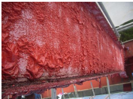
塗膜剥離剤処理
